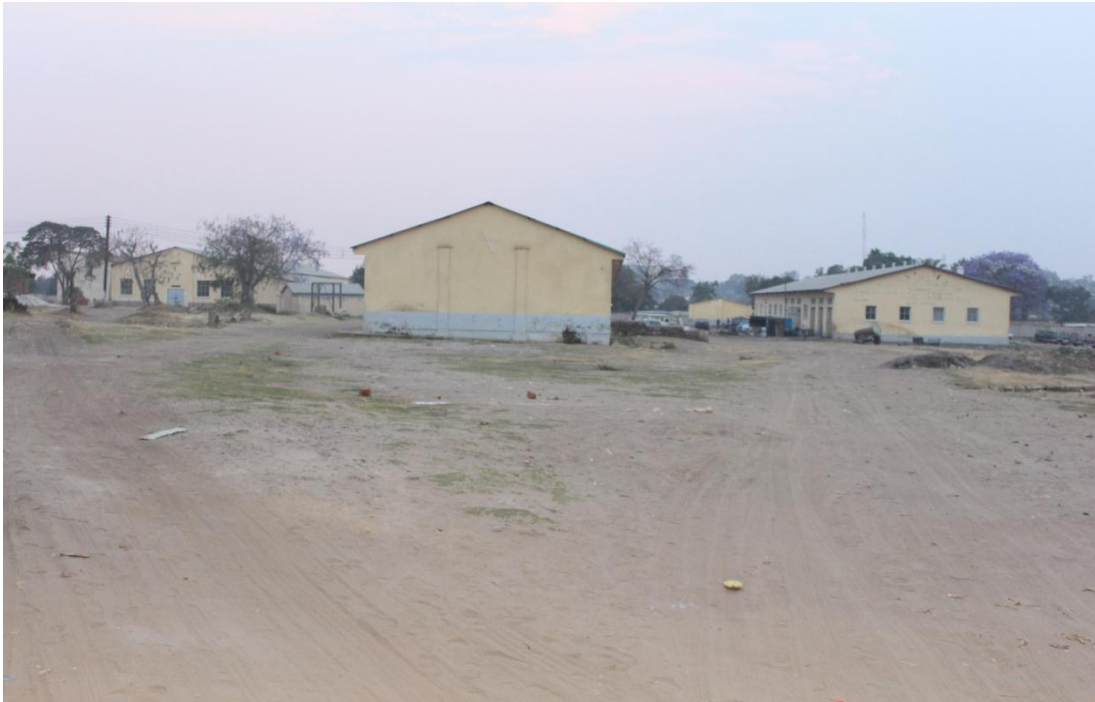
Photo ADDH du 28/07/2016 : Bâtiments ITIMA Réhabilités par KCC.
