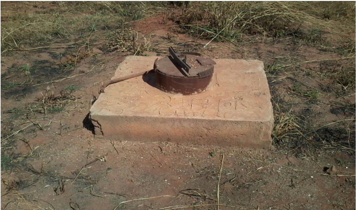
Photo ADDH du 09/07/2016 : Puits foré par KCC à TSHAMUNDENDA non encore opérationnel.
