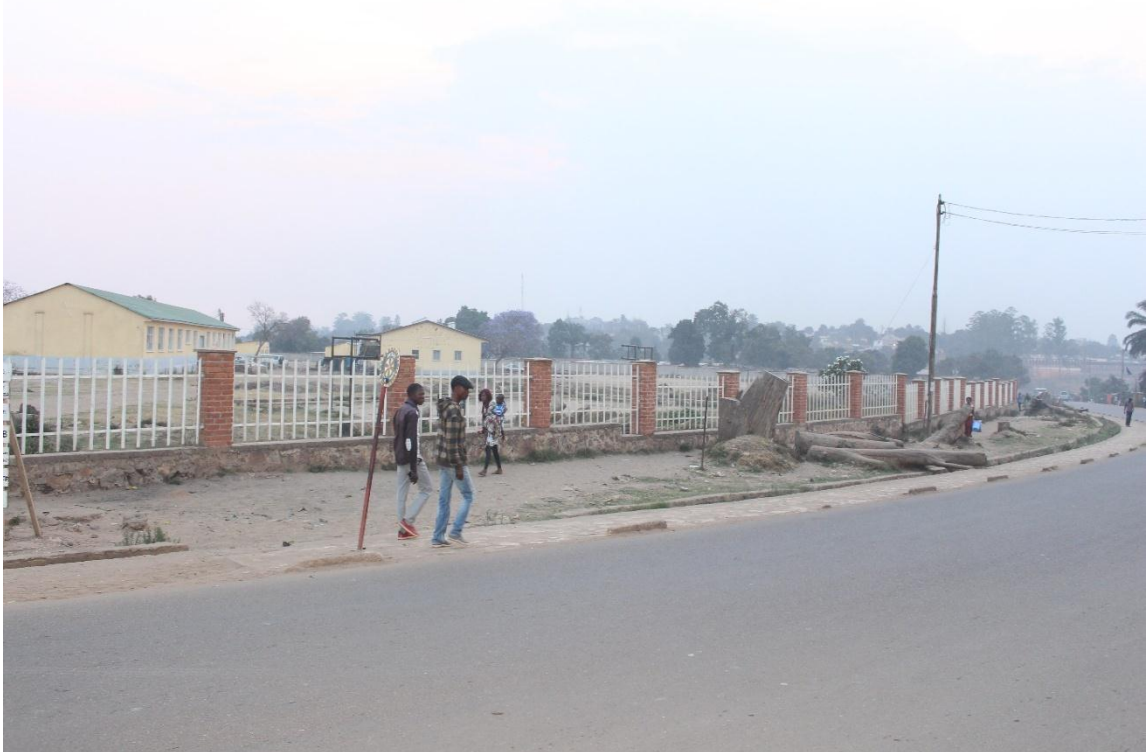
Photo ADDH du 28/07/2016 : Clôture ITIMA construite par KCC
